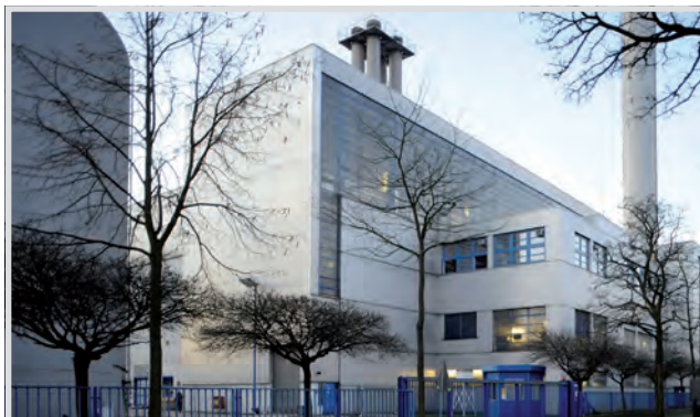
Fig. 12: Fuel bunker at the Märkisches Viertel power plant. Source: Vattenfall Europe Wärme
