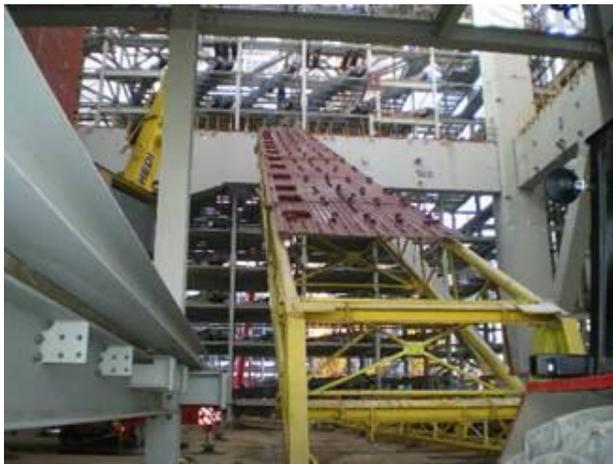
**Abbildung 4: Einsatz einer Traverse während der Montage auf der Baustelle**
