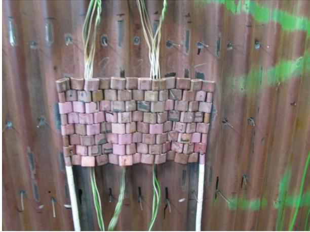
**Abbildung 2: Lokale Erwärmung einer gasdichten Membranrohrwand mit Heizmatte**
