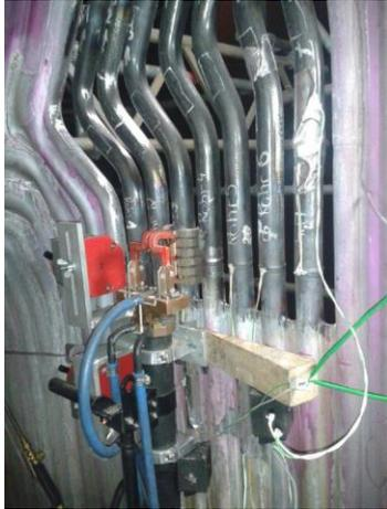
**Abbildung 3: Induktiv-Glühung an einer Rohrschweißnaht**
