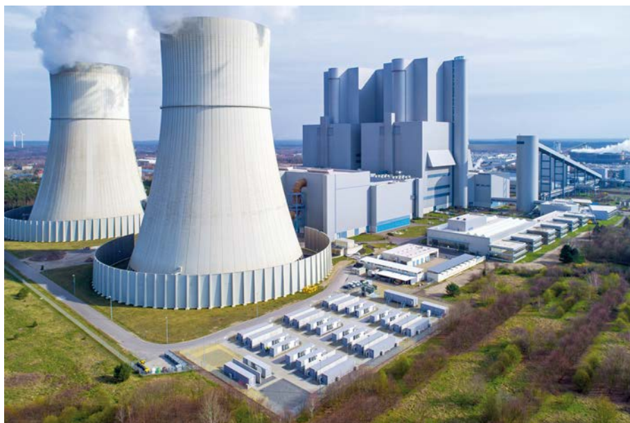
Bild 1. BigBattery Lausitz am Kraftwerksstandort Schwarze Pumpe.
