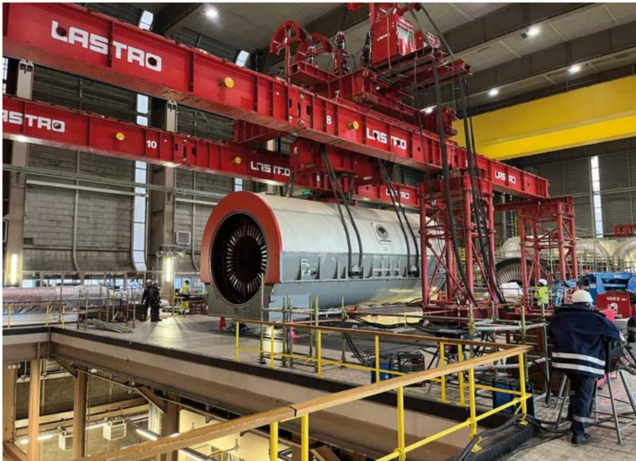
Bild 3. Schwerlasthub Generatorständermittelteil.
