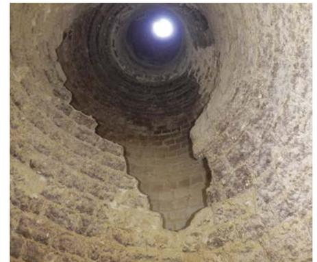
Bild 1. Schaden Kamin: Dank hochauflösender Kamera, die in der Elios Drohne verbaut ist, sind Schäden deutlich zu erkennen. Hier sieht man eindeutige Schäden an der inneren Auskleidung in einem Kamin.
