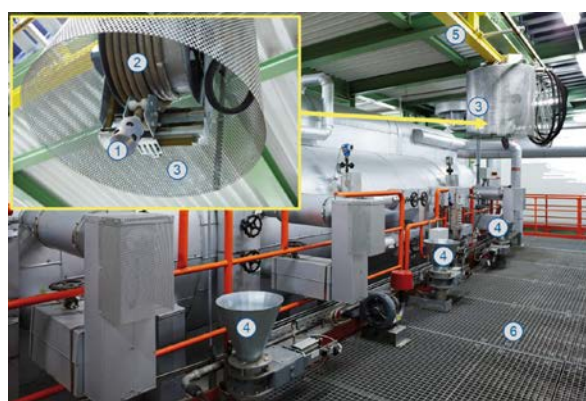
Bild 8. Wandheizflächen-Sprühreinigung.
