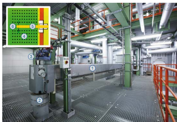
Bild 9. Heizflächenreinigung Konvektions-Heizflächen (3. Zug).
